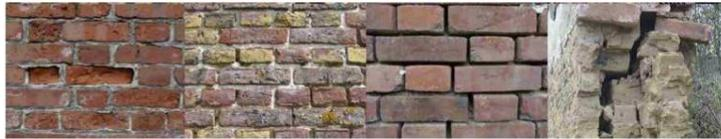
Lorsque seuls les joints sont « mangés », il est possible de les refaire en prenant comme principe de rejointoyer avec le même matériau de joint. En effet, il faut faire attention à ne pas mettre de ciment alors que le joint initial est fait à la chaux (voir Les Essentiels – *Information* n° 42 Chaux et ciment, à ne pas confondre). Un joint mal réalisé peut entraîner une désagrégation du mur encore plus rapide que si rien n'avait été fait.
