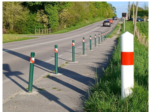
Potelets posés Route de Rouen afin de sécuriser la circulation des piétons.
